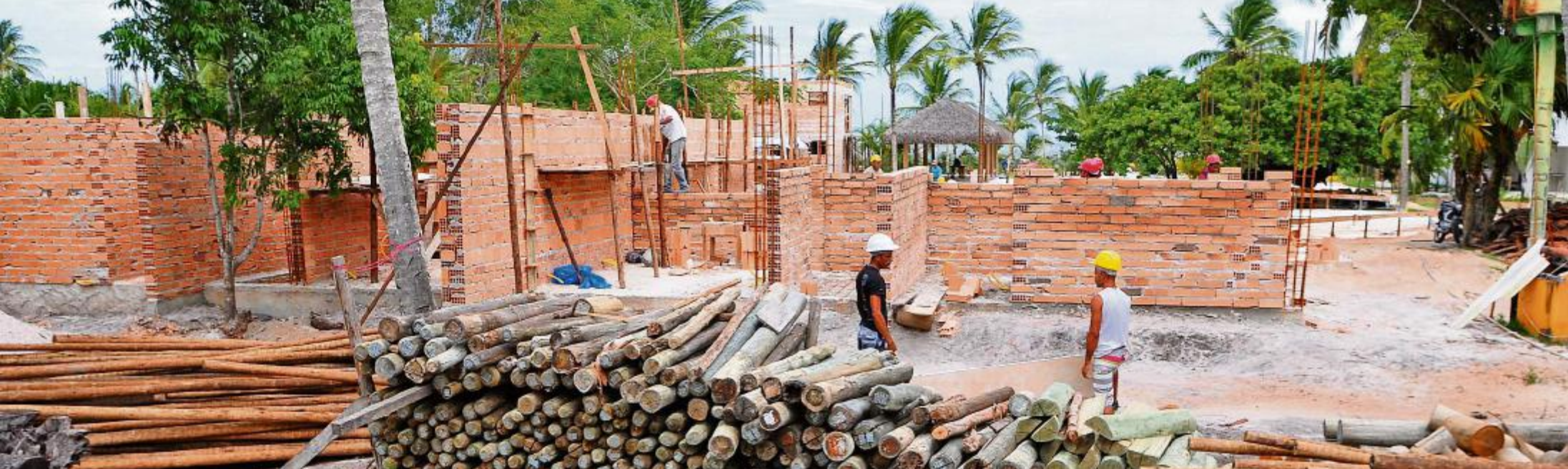
Aus dem Kinderzimmer der Nachbarn: Ein «verbotener» Blick auf die Baustelle des WM-Quartiers der deutschen Fussballnationalmannschaft in Santo André.
